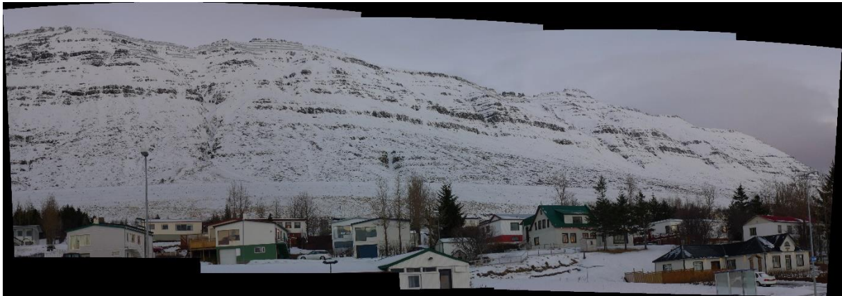
Mynd 3 Tröllagiljagarður séður frá byggð. Samsett mynd. Ljós mynd: Verkís
