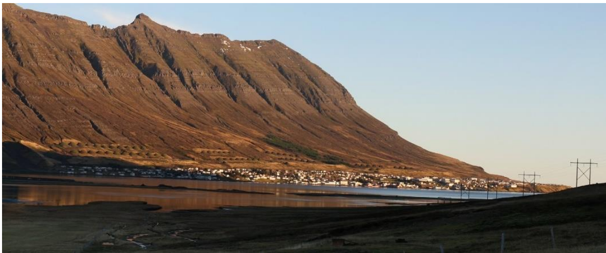
Mynd 46 Útsýni yfir Norðfjörð á Neskaupstað og varnarvirkin tvenn sem komin eru og búið er að teikna fyrirhuguð varnarvirki inn á myndina.
