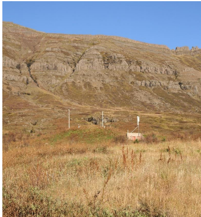
Mynd 31 Horft upp að vatnstanki bæjarins neðan Urðarbotns. Mynd tekin í nóvember 2015.
