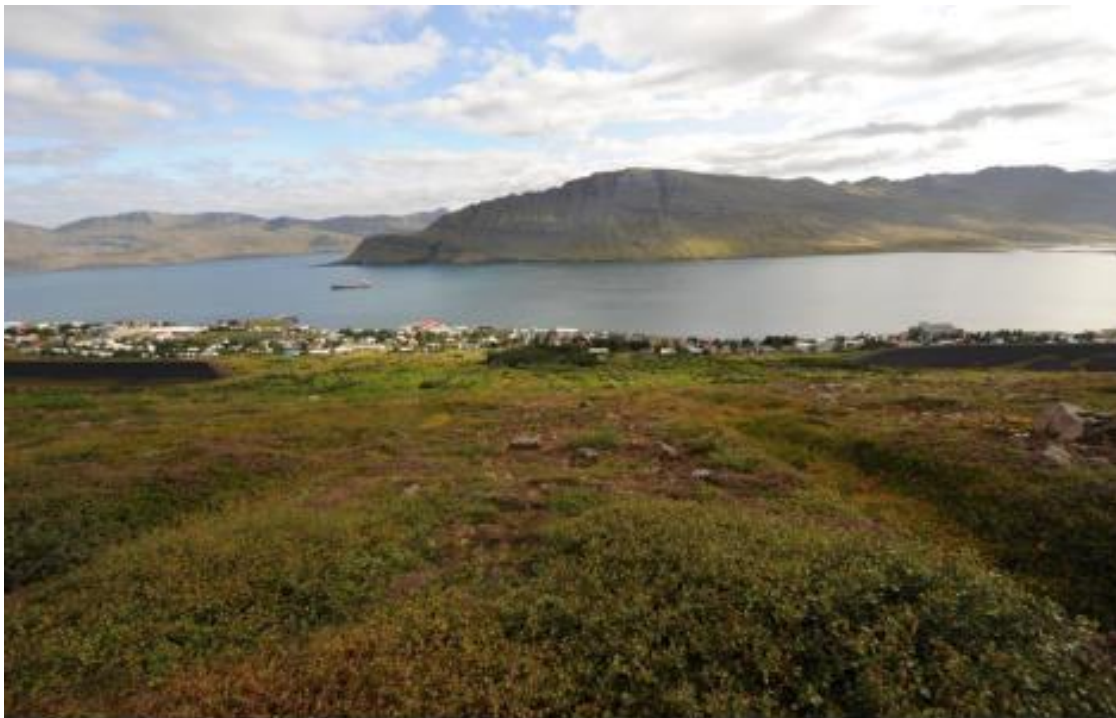
Mynd 34 Ásýnd frá svæðinu neðan Urðarbotns, milli Drangagils (til vinstri) og Ytra-Tröllagils (til hægri), og sést í báða varnargarðana sem búið er að reisa. Mynd tekin úr skýrslu Verkís (6 bls. 28).
